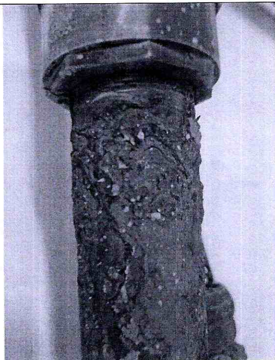
Estado de deterioro de las tuberías y válvulas
