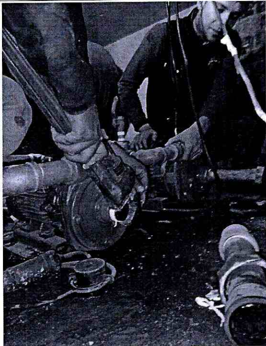
Desmonte tuberías corroídas
